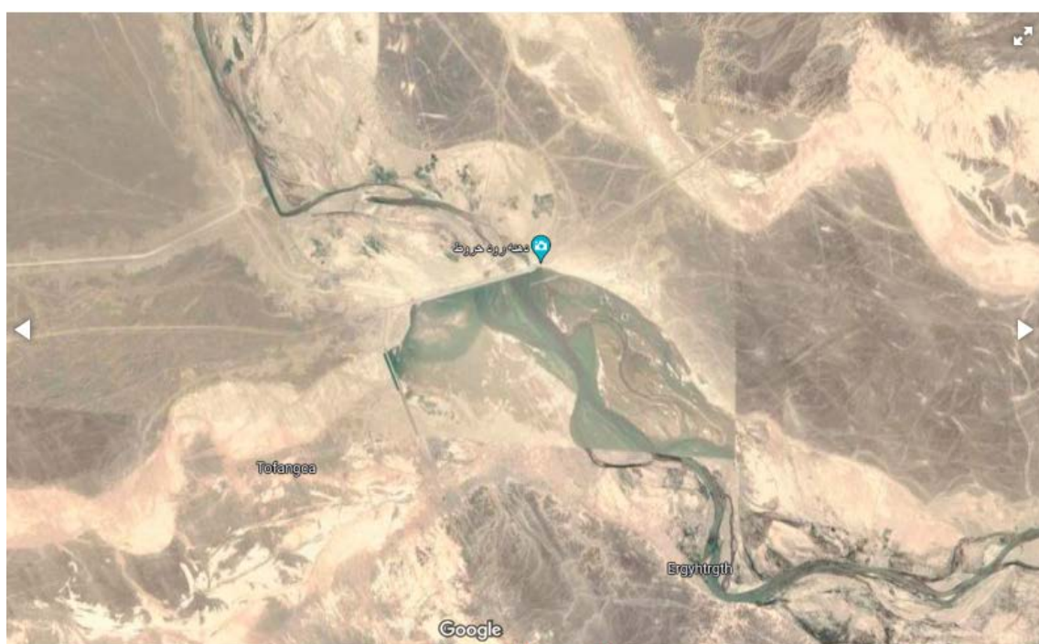
Участок реки Гильменд, на котором расположена плотина, до ее запуска в эксплуатацию, 2019 год.
