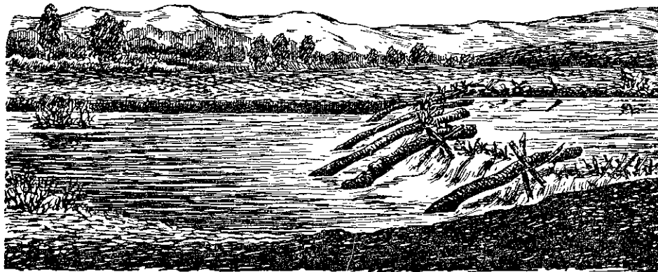
Рис. 55. Простейший способ подпруживания реки посредством треног, нагруженных камнем и хворостом под Кабулом. По фот. Д. Д. Букиннича.
