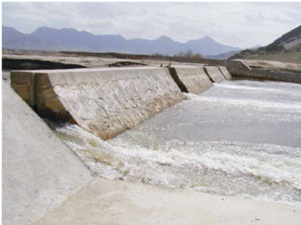
Рис. 4. Новая плотина на реке Лохар
