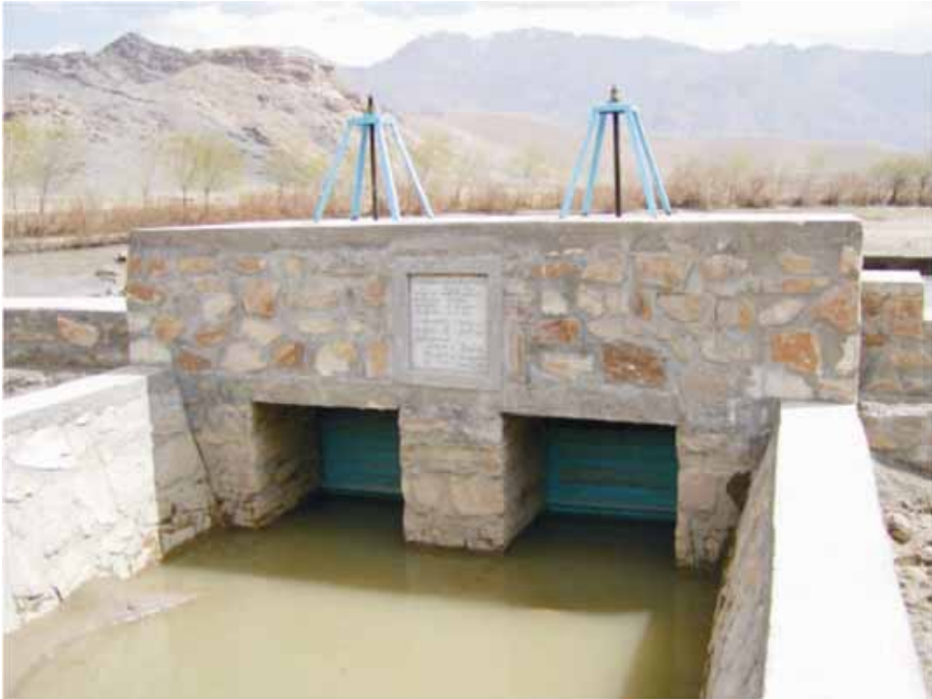
Рис. 5. Типичный водозабор на канале, оборудованный шлюзом
