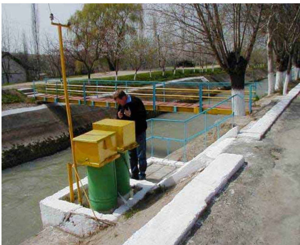
Гидроучасток «Палванташ» (ЮФМК)
