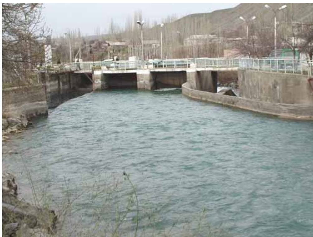
Головное сооружение ААК
