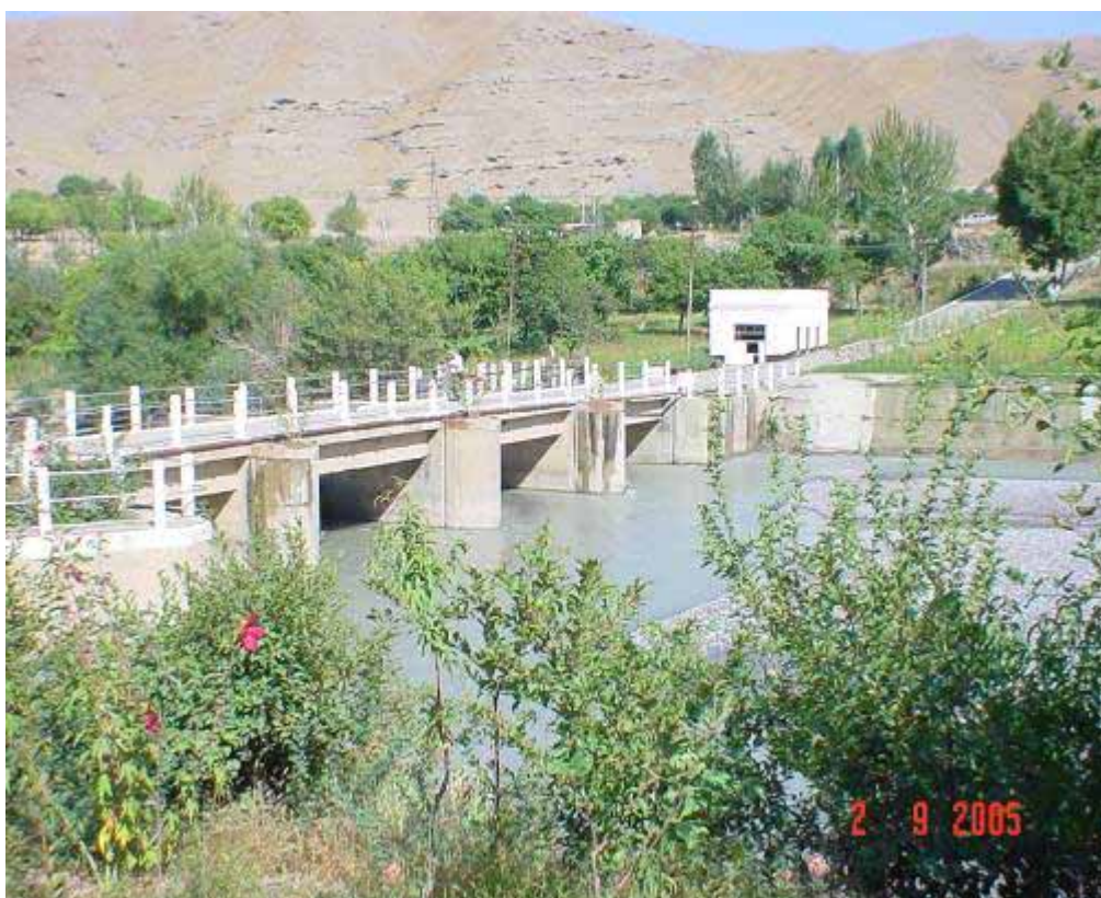
Плотина на реке Ходжабакиргансай
