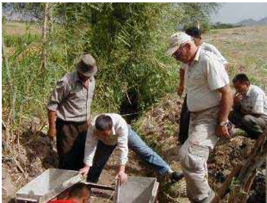
9 – расм. САНИИРИ новини қуйиш учун метал опалубкани ўрнатиш.
