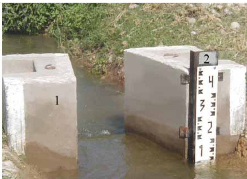
6 - Расм. САНИИРИ нинг сув ўлчаш нови, юқори бьеф томони 1 - кириш қисми, 2 - гидрометрик рейка.
