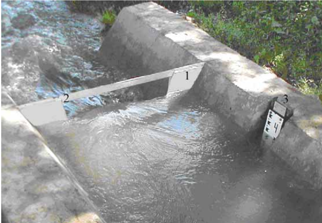
Рис.1. Водослив Чиполетти (вид с верхнего бьефа)
