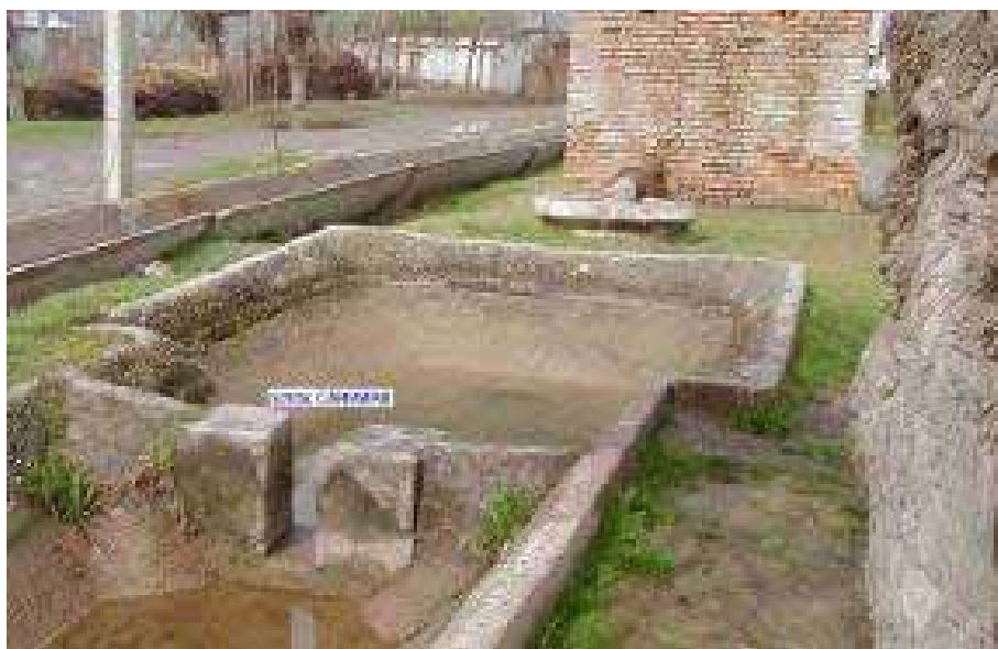
16 - расм. Тик дренаж скважинасининг чиқиш қисмида жихозланган САНИИРИ нинг сув ўлчаш нови
