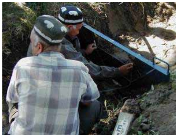
3 –расм. Водосливни сув тўлдирилган тиник найча ёрдамида ўрнатиш
