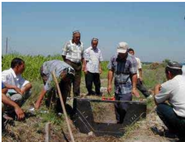
2 – расм. Водосливни қурилиш шайтони ёрдамида ўрнатиш
