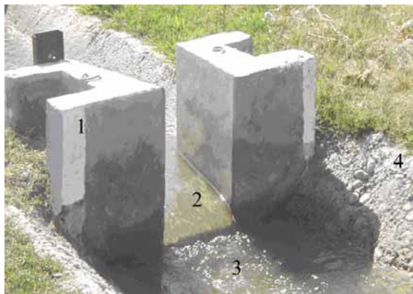
7 - Расм. САНИИРИ нинг сув ўлчаш нови, пастки бьеф томони 1 - чиқиш қисми, 2 - новнинг туби, 3 - чуқурча, 4 - пастки бьефда канал ёнбағирларини маҳкамлаш.
