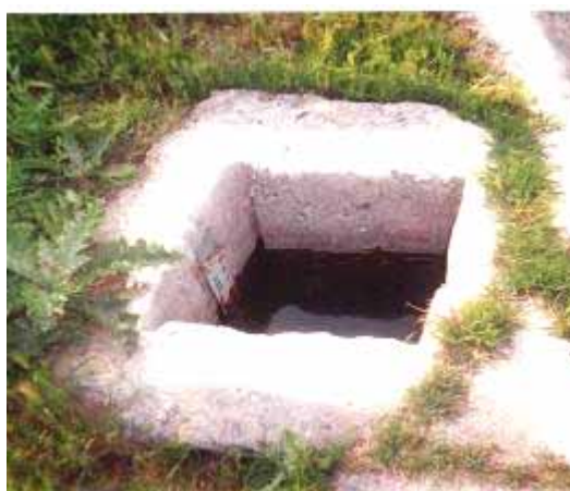
б) успокоительный колодец
