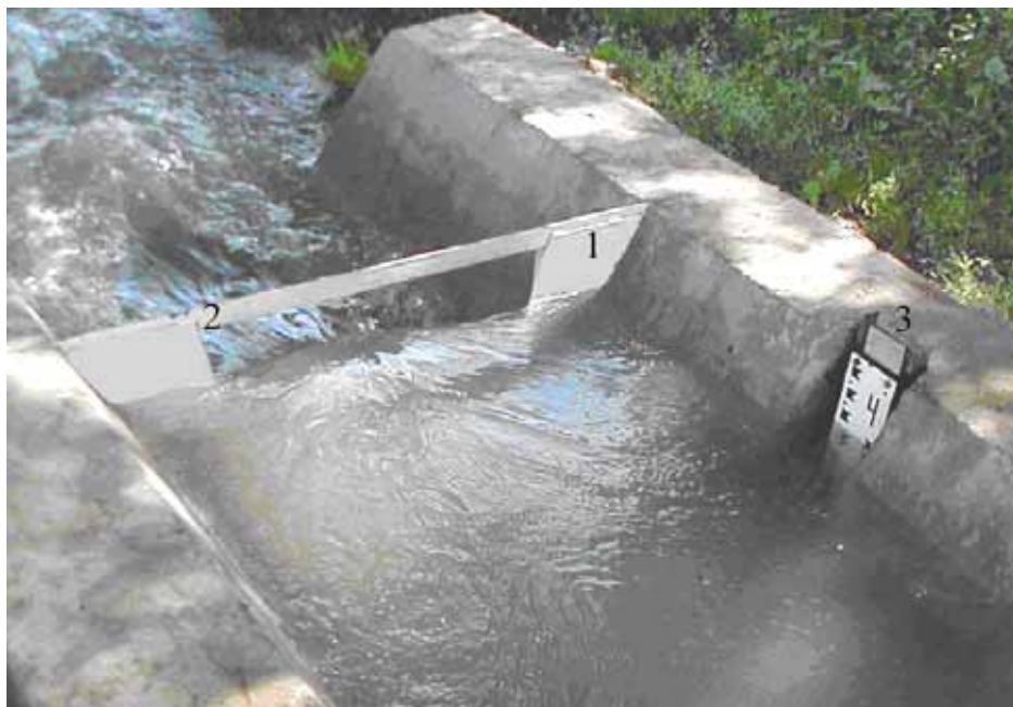
4 - расм. Чиполетти водосливи (юқори бьефдан кўриниши). 1 - ЧВ-50 водосливи; 2 – маҳкамлаш қирраси; 3 – сатхўлчагич ўрнатилган тинчлантириш чуқурчаси.
