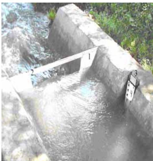
Рис. 3.1. Водослив Чиполетти (вид с верхнего бьефа):
